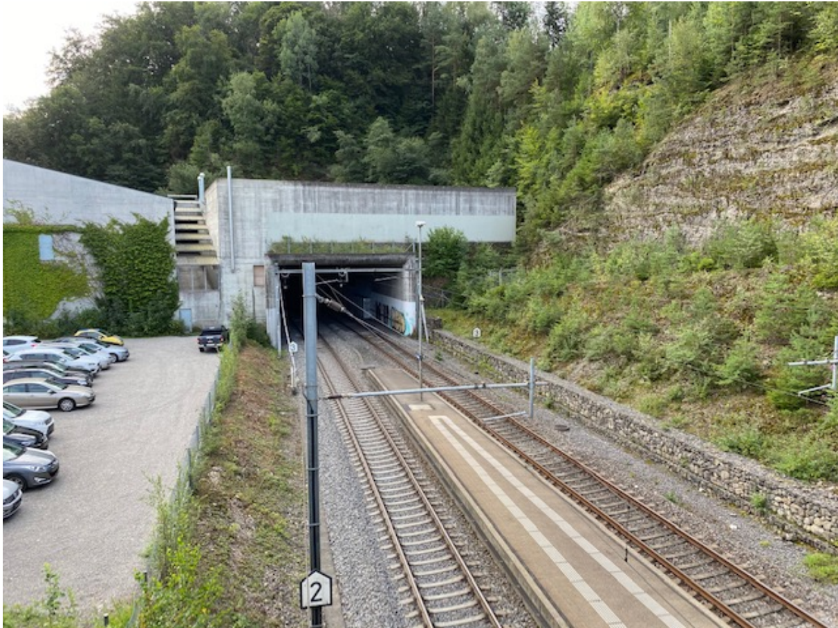
Abb. 20.5. Der Eingang zum 1990 erbauten Aathal-Tunnel, rechts davon die Reste einer ehemaligen Kiesgrube
